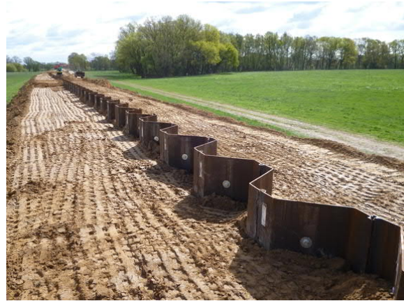
Abbildung 13: Mit Spundwand gesicherter Deich [polder-loebnitz.de]
