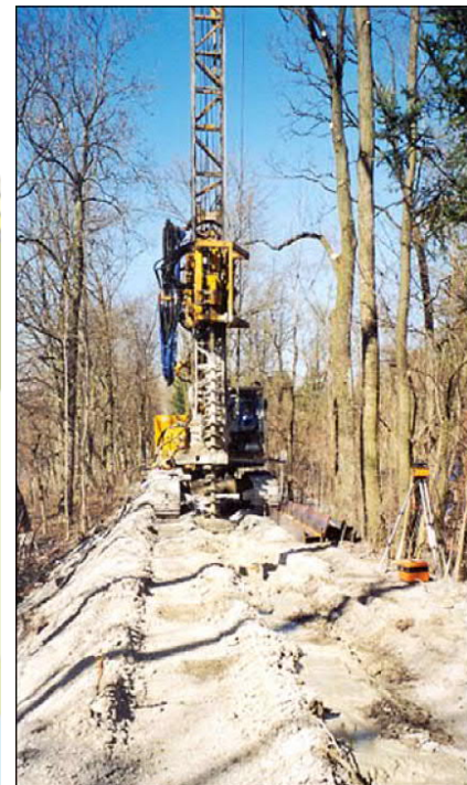
Abbildung 7: Dichtwand im MIP-Verfahren [Bauer Spezialtiefbau GmbH]
