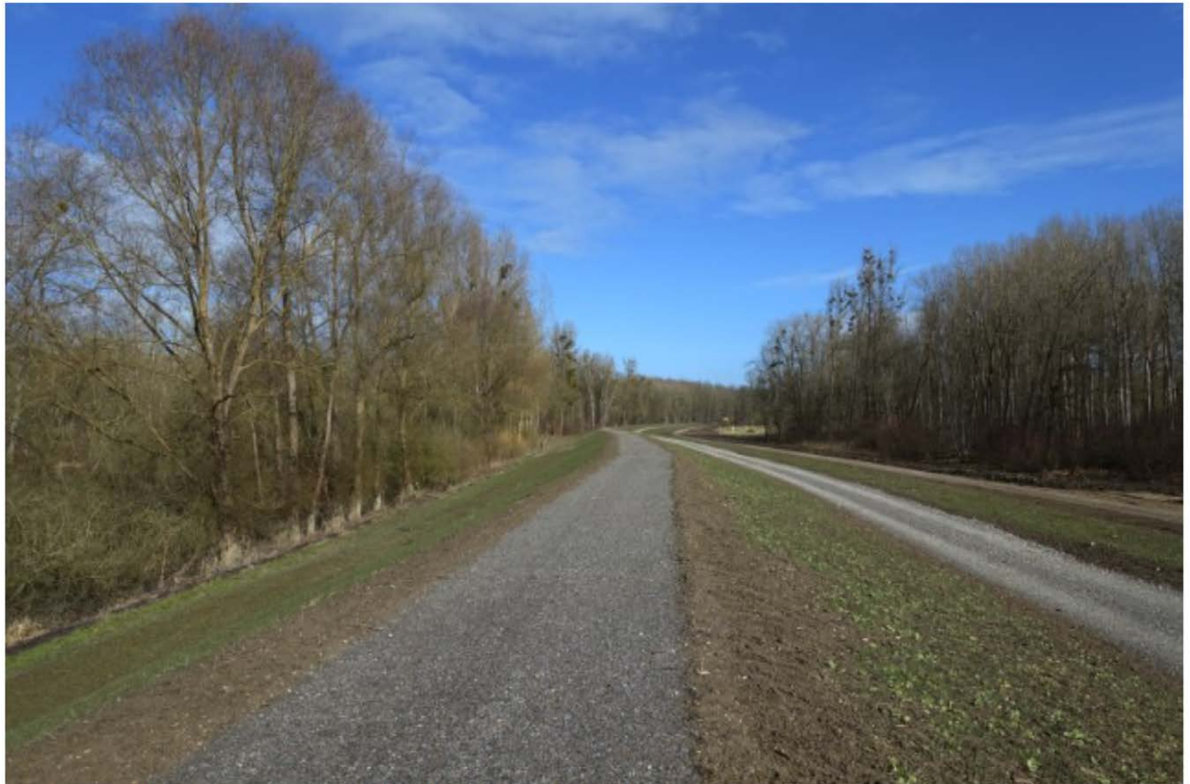
Fertiggestellter Rheindammabschnitt im Bereich Dettenheim Copyright: RP Karlsruhe
